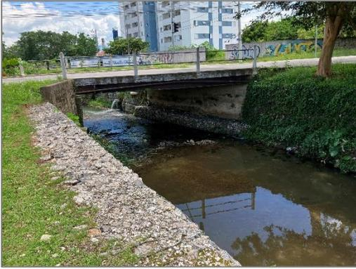
FIGURA 2 – CANAL ABERTO COM PAREDES REVESTIDAS POR GABIÃO, RUA BLUMENAU, TAUBATÉ-SP
