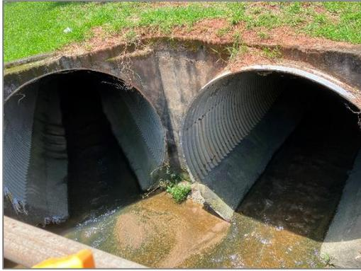
FIGURA 4 – TUBULAÇÃO EM AÇO CORRUGADO, AV. ANTÔNIO GARCIA DA CUNHA, TAUBATÉ-SP
