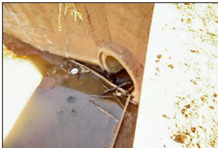
Figura 17 – Entrada do bueiro com tubo de concreto de 1,80 m
