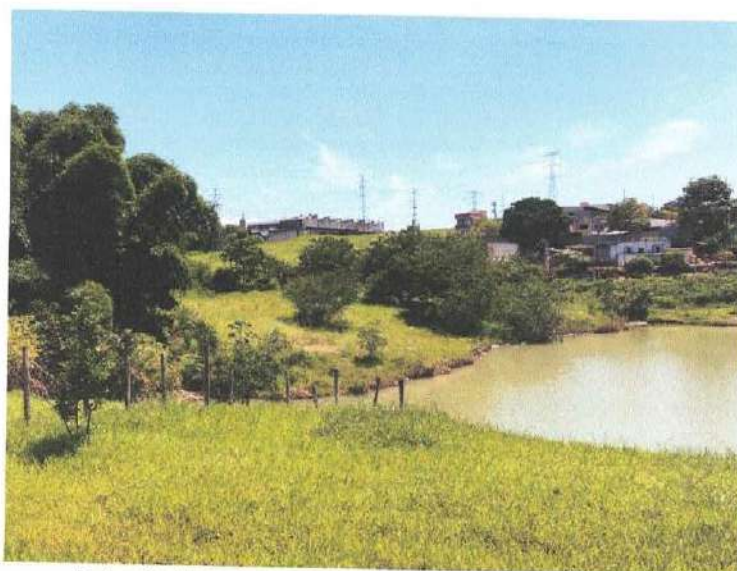
Foto nº 4: Vista da margem esquerda do talude de montante;
