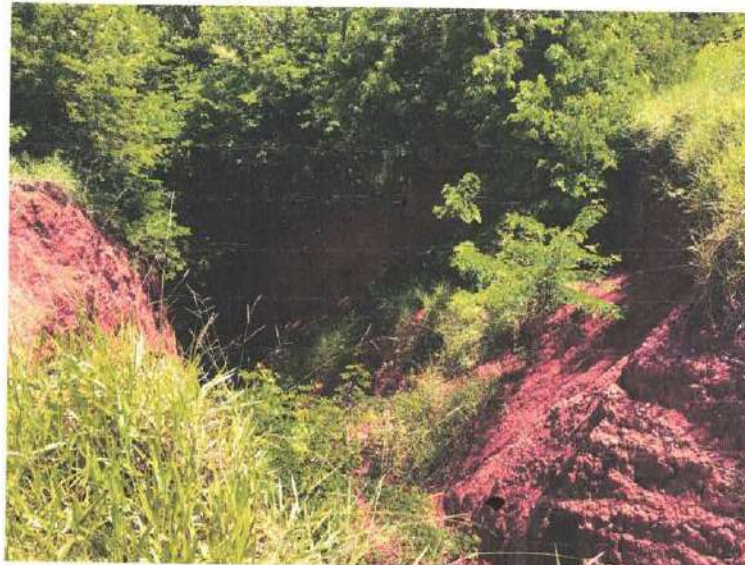
Foto nº 7: Vista do processo erosivo desencadeado no final da "vala";
