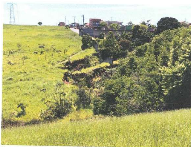
Foto nº 10: Vista do processo erosivo desencadeado na saída do antigo vertedor (Ombreira direita);
