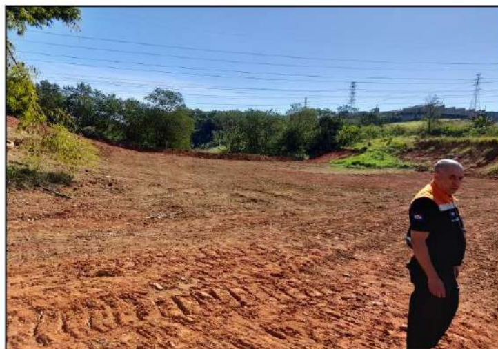
Figura 13 – Vista de jusante do maciço, lado direito
