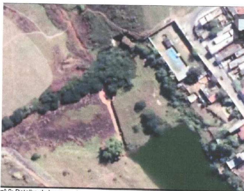
Foto nº 2: Detalhe do barramento, vegetação, vertedores e processos erosivos (Google Maps®);
