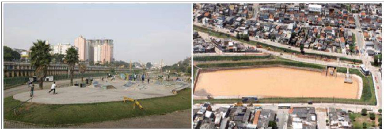
FIGURA 24 – ÁREA DE LAZER EM RESERVATÓRIO DE DETENÇÃO, SÃO PAULO - SP (ESQUERDA), RESERVATÓRIO DE DETENÇÃO EM SÃO BERNARDO DO CAMPO - SP (DIREITA)
