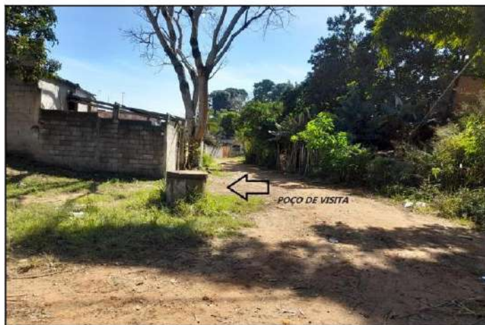
Figura 23 – Trecho canalizado com ocupação irregular. Tubos fazem o papel de poços de visita
