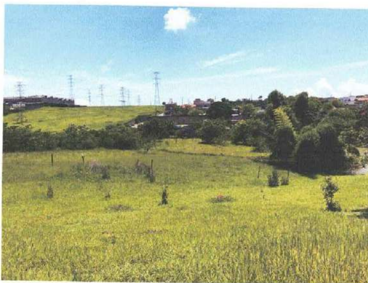
Foto nº 3: Vista geral da margem esquerda do corpo da barragem;
