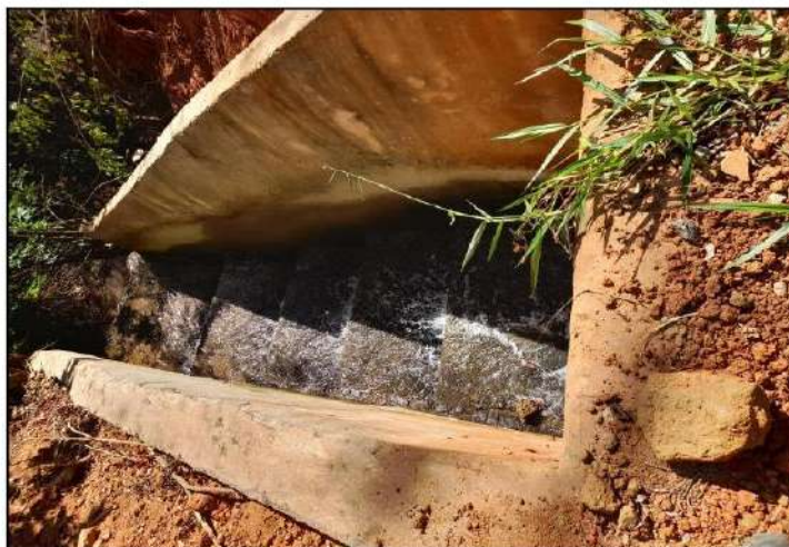
Figura 18 – Saída do bueiro com dissipador em degraus
