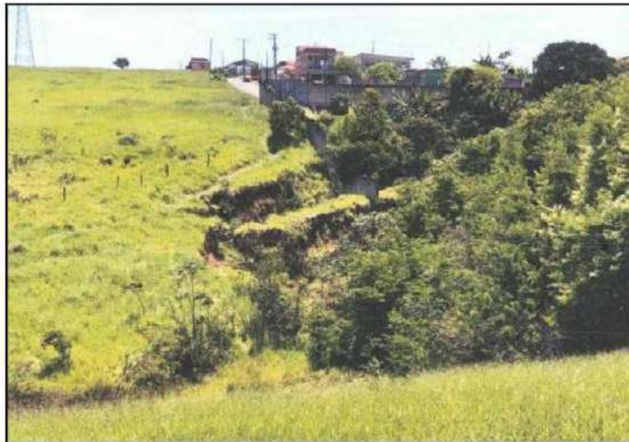
Figura 5 – Processo erosivo provocado por vala na ombreira direita, ameaçando as construções
