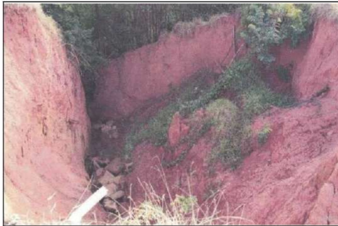
Figura 4 – Processo erosivo estabelecido no trecho final da vala
