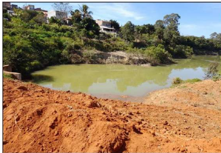
Figura 11 – Situação atual do lago. Observar a margem direita, composto de solo arenoso, em processo de desbarrancamento
