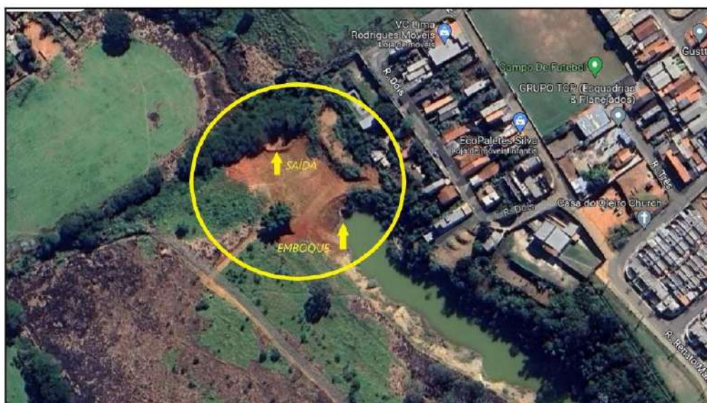
Figura 2 – Vista da situação atual do local
