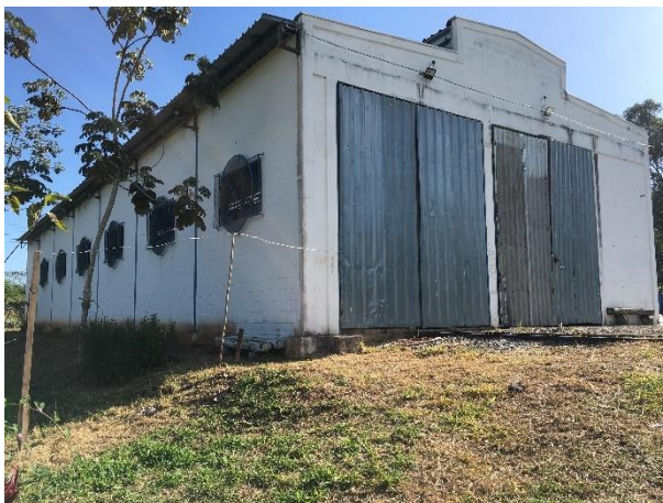
FIGURA 126 – GALPÃO DA MARIA FUMAÇA FONTE: ACERVO DO AUTOR, 2022
