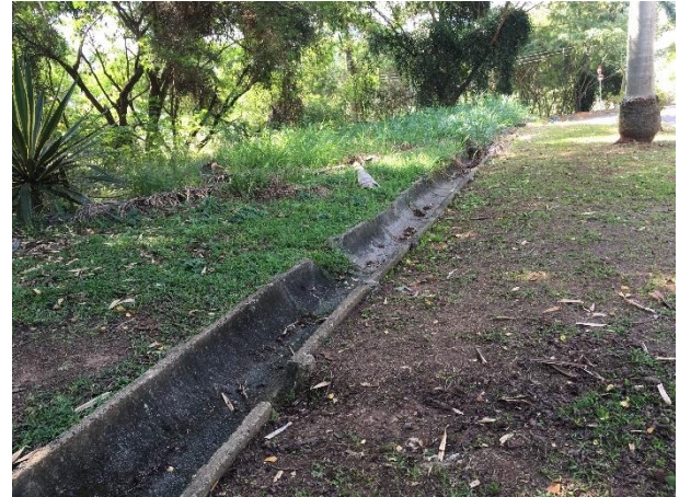
FIGURA 107 – VALA DE DRENAGEM FONTE: ACERVO DO AUTOR, 2022
