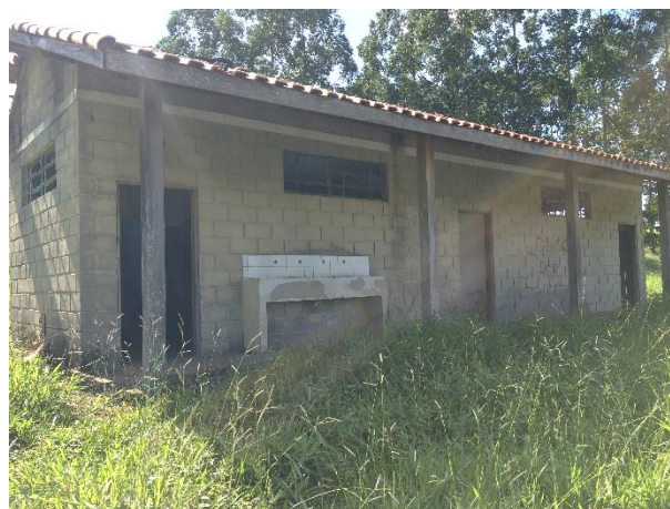
FIGURA 123 – SANITÁRIO 05 FONTE: ACERVO DO AUTOR, 2022
