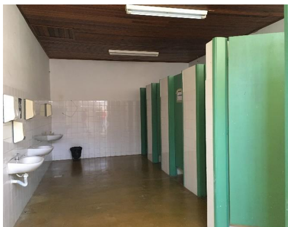
FIGURA 117 – SANITÁRIO 01 FONTE: ACERVO DO AUTOR, 2022
