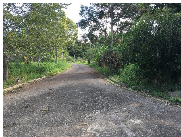
FIGURA 105 – PAVIMENTAÇÃO – VISTA 02 FONTE: ACERVO DO AUTOR, 2022
