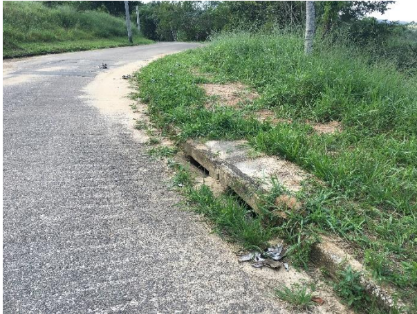
FIGURA 106 – BOCA DE LOBO FONTE: ACERVO DO AUTOR, 2022
