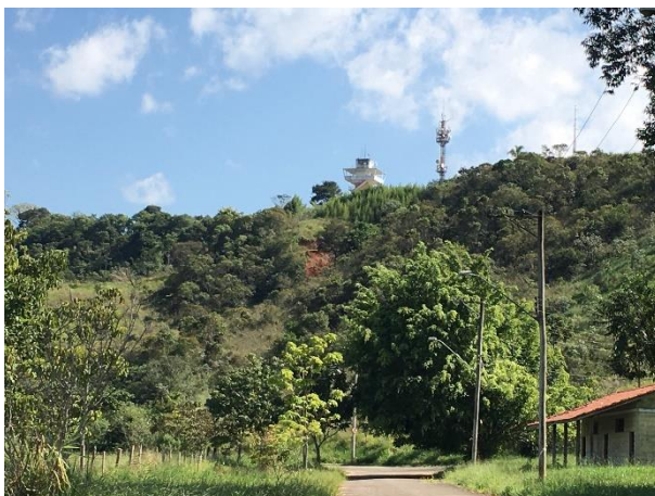
FIGURA 14 – EROSÃO – VISTA 01 FONTE: ACERVO DO AUTOR, 2022
