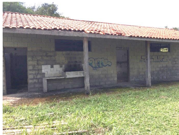
FIGURA 122 – SANITÁRIO 04 FONTE: ACERVO DO AUTOR, 2022
