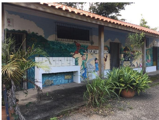
FIGURA 119 – SANITÁRIO 02 FONTE: ACERVO DO AUTOR, 2022
