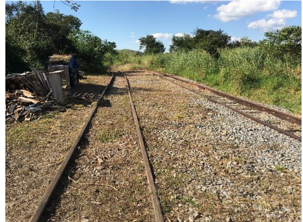
FIGURA 181 – DISPOSIÇÃO INADEQUADA DE RESÍDUOS DA CONSTRUÇÃO CIVIL FONTE: ACERVO DO AUTOR, 2022
