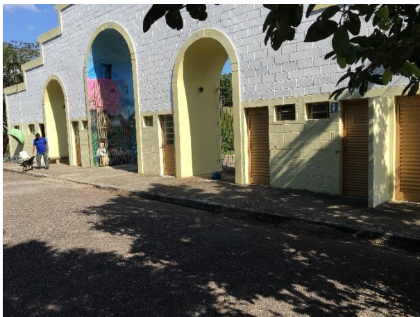
FIGURA 121 – SANITÁRIO 03 FONTE: ACERVO DO AUTOR, 2022
