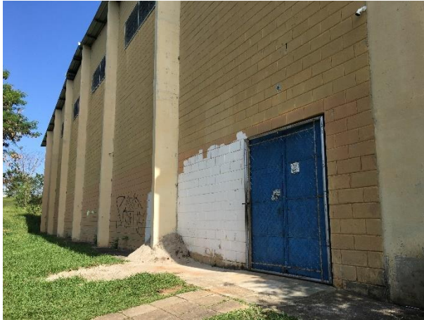
FIGURA 81 – QUADRA – VISTA EXTERNA FONTE: ACERVO DO AUTOR, 2022
