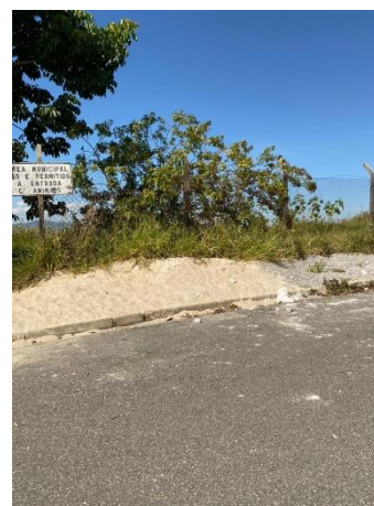
FIGURA 140 – DISPOSIÇÃO INADEQUADA DE RESÍDUOS DA CONSTRUÇÃO CIVIL FONTE: ACERVO DO AUTOR, 2022
