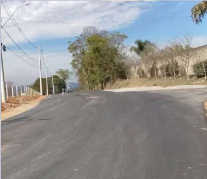
Pavimentação estrada do Pinheirinho – Parceria com o DER
