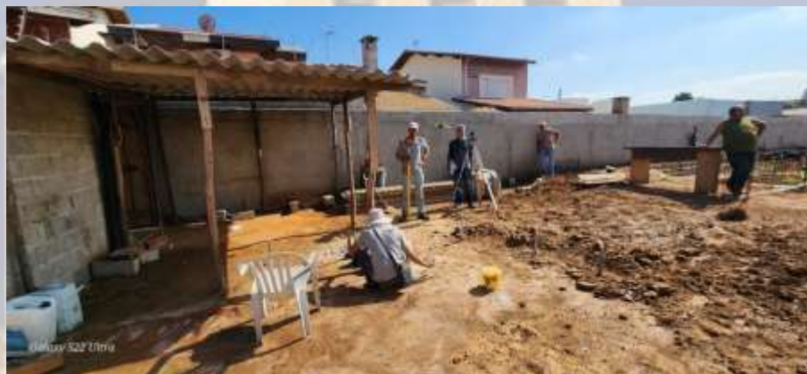
Marcação de Obra
