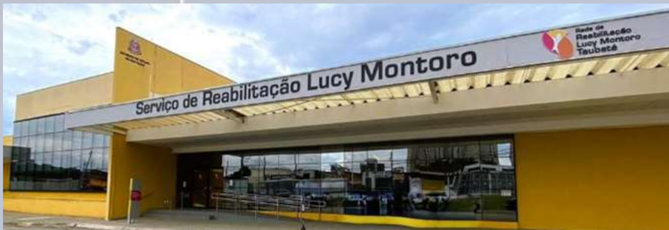
Serviço de Reabilitação Lucy Montoro
