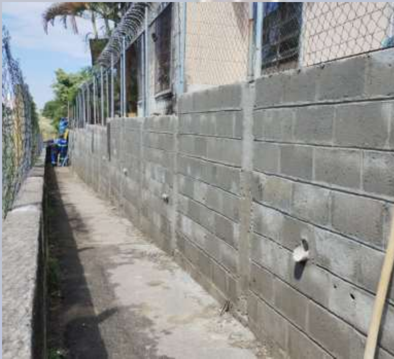
Alvenaria – EMEI Água Quente
