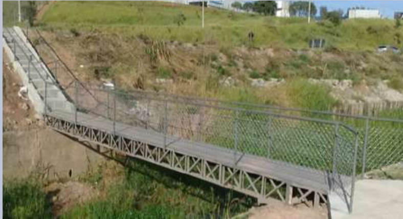
Construção de passarela e guarda corpo – Córrego Santa Tereza
