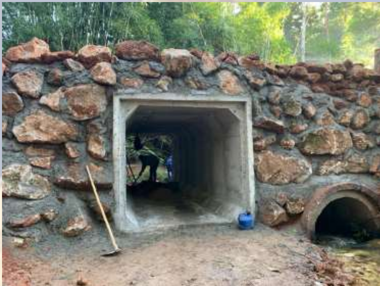
Ponte de Aduelas – Estrada Pedra Grande
