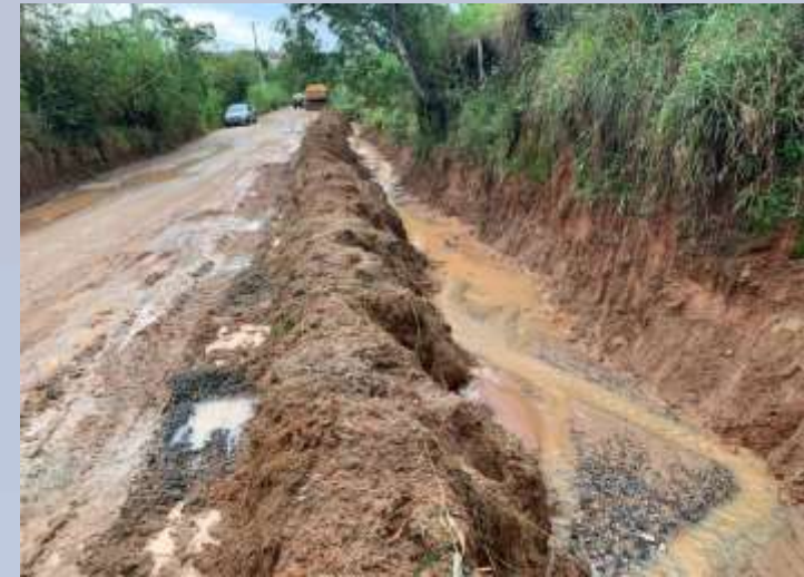
Drenagem Estrada Itapeçerica
