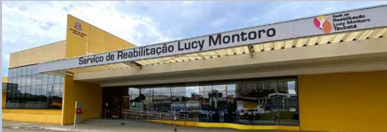
Serviço de Reabilitação Lucy Montoro
