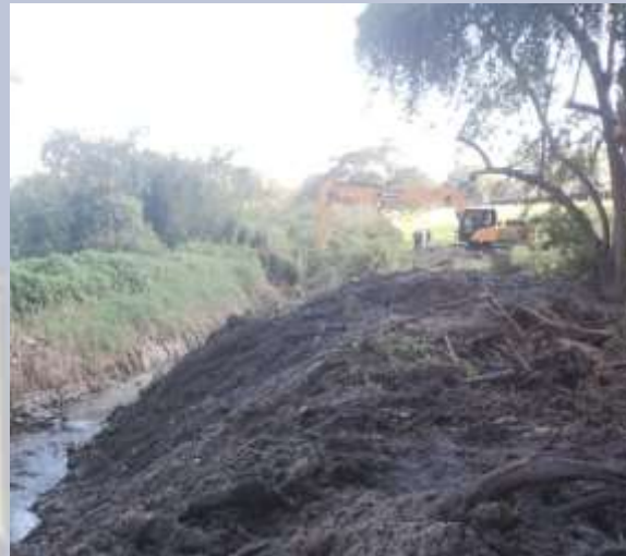
Limpeza de Córrego – Gurilândia
