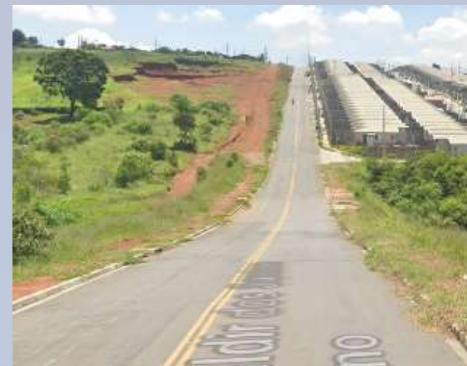
Pavimentação, drenagem e recapeamento em diversos ponto do município
