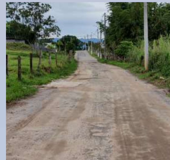
Pavimentação e Drenagem – Estrada João Gadioli - Quiririm
