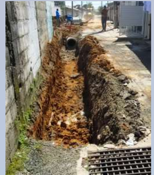
Drenagem – Vila Bela
