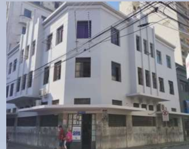
Adaptações elétricas, hidráulicas e construção civil - Tesourinho
