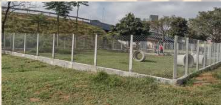
Execução de Parcão - Flamboyán
