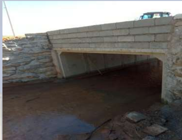
Alteamento de estrada e Aduelas – Estrada do Una
