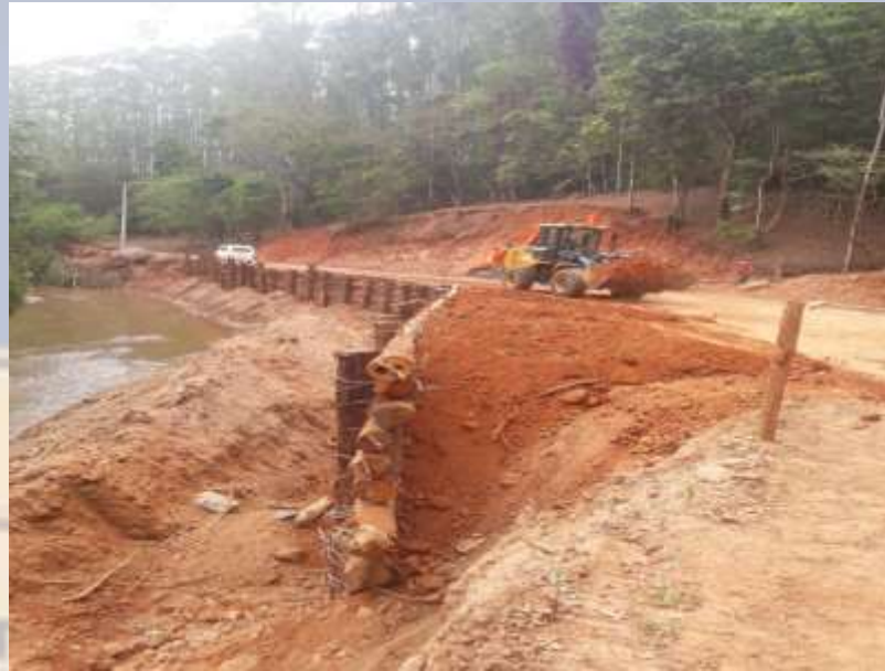
Alargamento de pista e Contenção tipo paliçada – Estrada do Una
