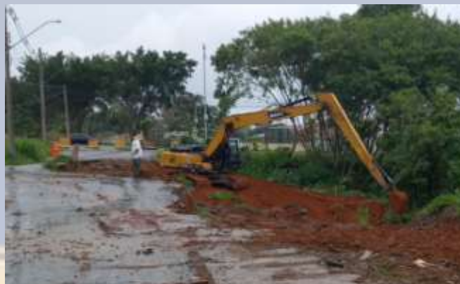
Contenção – Av. Dr. Avedis Narras, Portal da Mantiqueira
