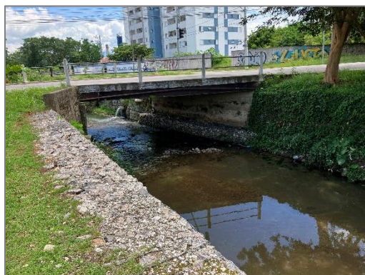
FIGURA 2 – CANAL ABERTO COM PAREDES REVESTIDAS POR GABIÃO, RUA BLUMENAU, TAUBATÉ-SP FONTE: ACERVO DO AUTOR, 2023.
