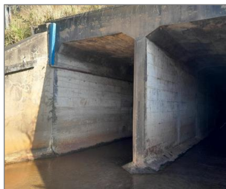
FIGURA 7 – ADUELA LOCALIZADA ABAIXO DE FERROVIA, TAUBATÉ-SP FONTE: ACERVO DO AUTOR, 2023.
