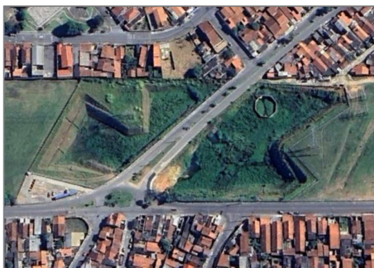
FIGURA 8 – RESERVATÓRIO DE CONTENÇÃO, RUA BRASILINA MOREIRA DOS SANTOS, TAUBATÉ-SP FONTE: GOOGLE EARTH, 2023.
