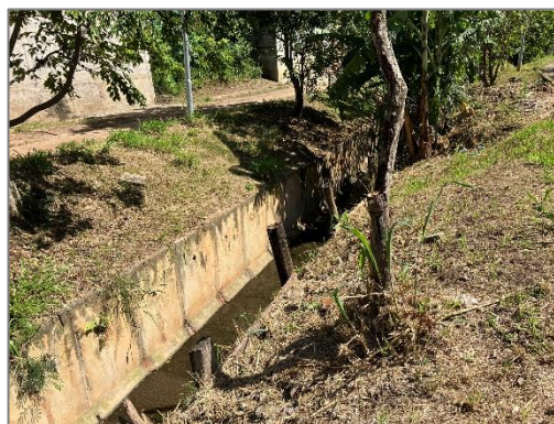
FIGURA 3 – CANAL ABERTO REVESTIDO POR CONCRETO, RUA PEDRO FRANCISCO DOS SANTOS, TAUBATÉ-SP FONTE: ACERVO DO AUTOR, 2023.
