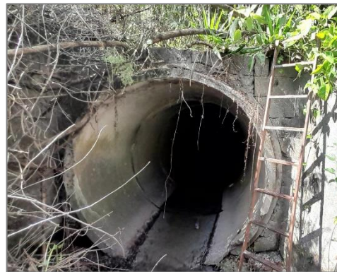
FIGURA 5 – TUBULAÇÃO EM CONCRETO, PRÓXIMO À RUA PAULO DIAS RAPOSO, TAUBATÉ-SP FONTE: ACERVO DO AUTOR, 2023.
