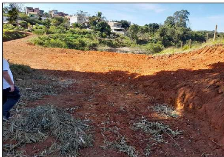
Figura 10 – Vista do maciço e da movimentação de terra a partir da margem esquerda
