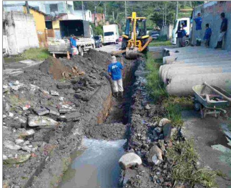
FIGURA 26 – TROCA DE TUBULAÇÃO EM REDE DE DRENAGEM, CARAGUATATUBA - SP FONTE: PREFEITURA MUNICIPAL DE CARAGUATATUBA, 2024.
