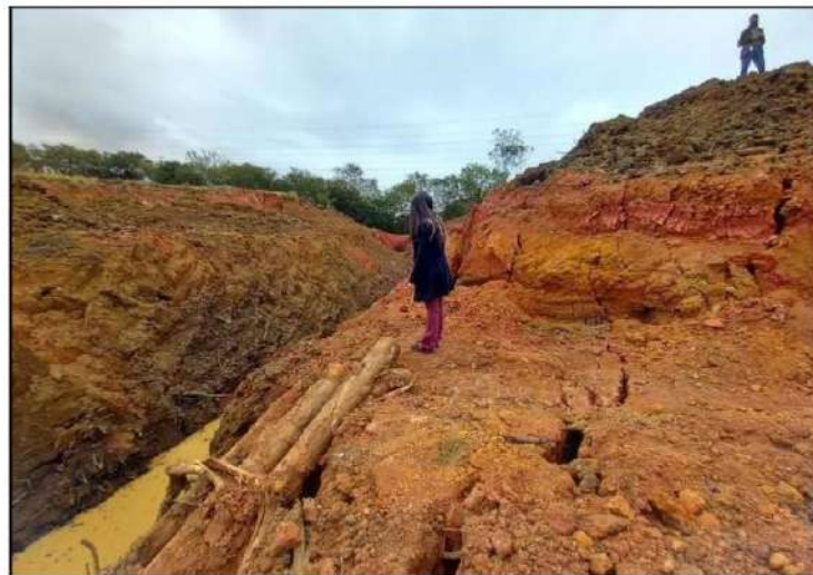
Figura 7 – Situação do maciço cortado transversalmente em 2021. Observar restos de troncos e fratura transversal no maciço
