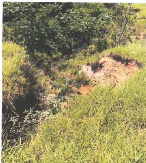
Foto nº 11: Vista de cima do antigo processo erosivo da ombreira direita.
