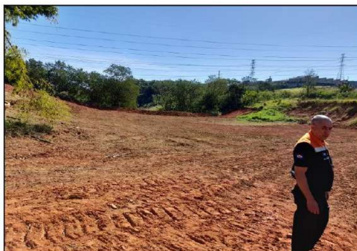
Figura 13 – Vista de jusante do maciço, lado direito
