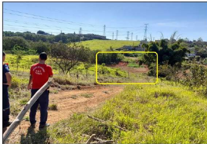
Figura 9 – Vista do local da barragem a partir da margem esquerda
