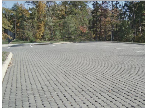
FIGURA 1 – PAVIMENTO PERMEÁVEL EM ESTACIONAMENTO FONTE: SOLUÇÕES PARA CIDADES, ABCP, 2021.
