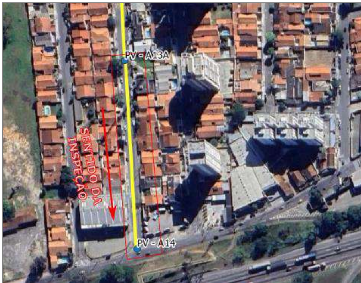
FIGURA 29 – TRECHO REFERENTE AO INÍCIO NO PV A13A, NO SENTIDO DO PV A14. ELABORADO PELO AUTOR, 2023.
