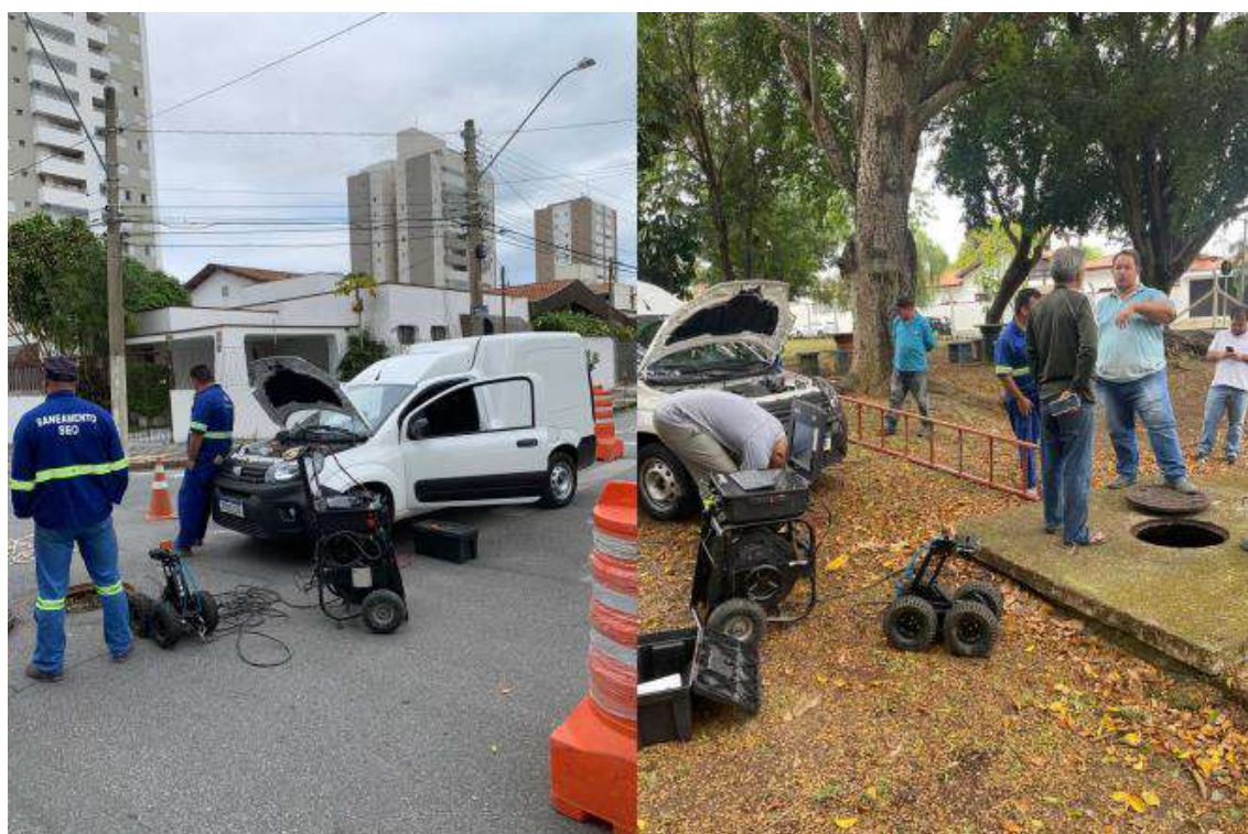
FIGURA 7 – IMAGENS DURANTE A AQUISIÇÃO DE DADOS VI ATRAVÉS DA INSERÇÃO DOS EQUIPAMENTOS POR PV'S. ELABORADO PELO AUTOR, 2023.
