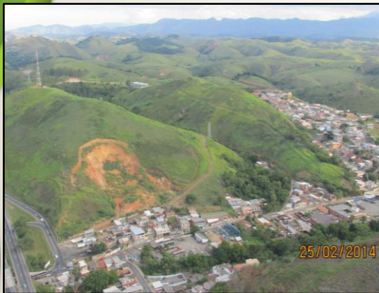
Cicatriz de escorregamento circular com degraus de abatimento, 2014
