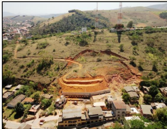
Cicatriz de escorregamento circular, 2012
