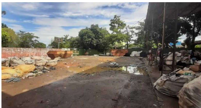
Figura 62: Vista geral do pátio.
