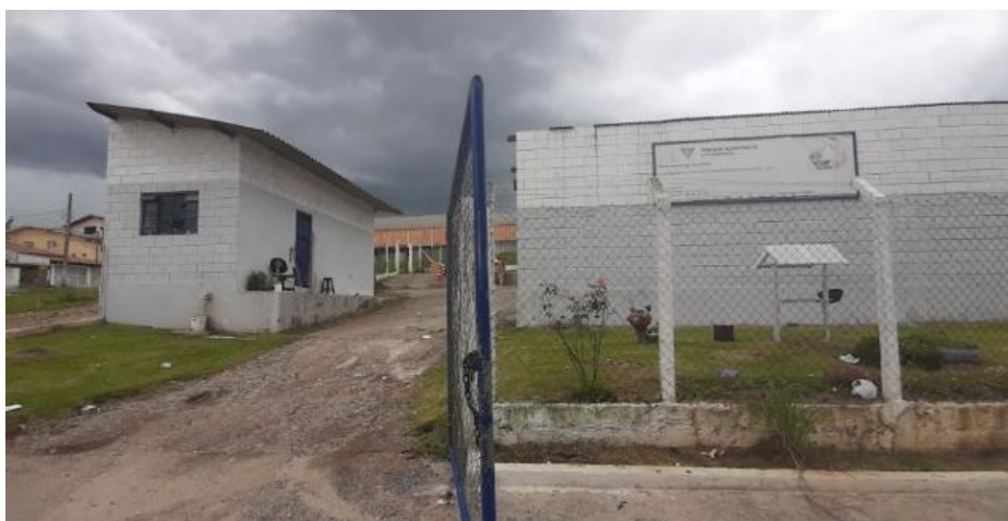
Figura 163: Entrada - PEV Parque Aeroporto.
