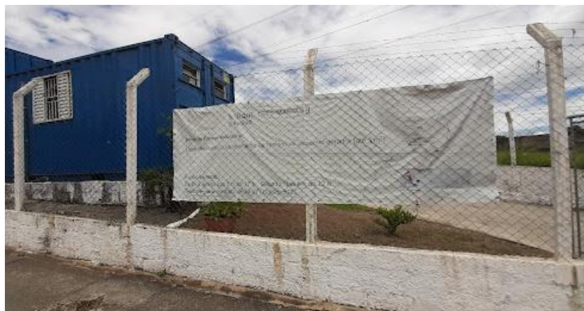
Figura 158: Vista externa - PEV Três Marias II.
