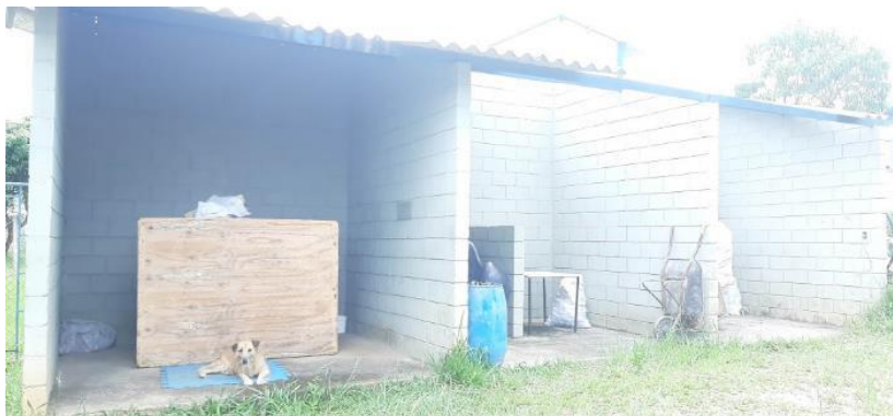
Figura 157: Local com baias para armazenamento de materiais.
