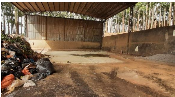
Figura 117: Vista interna da Unidade de Transbordo.
