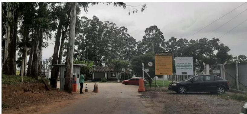
Figura 112: Entrada da Central de Tratamento de Resíduos Sólidos.
