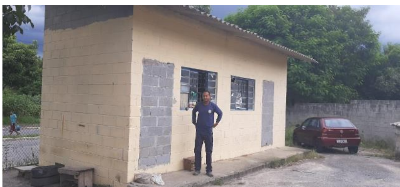
Figura 169: Unidade de Apoio – PEV Jardim Morisco.
