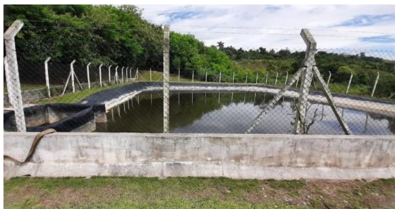
Figura 133: Vista geral da lagoa de armazenamento de chorume.
