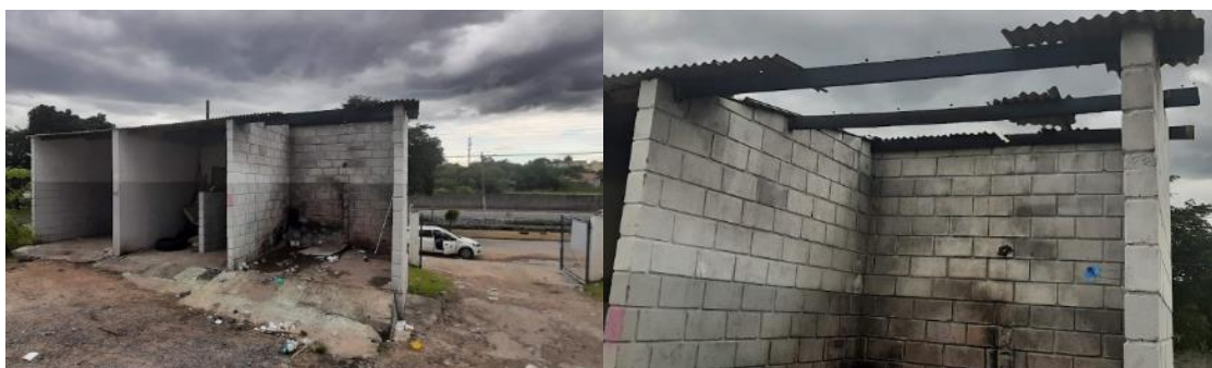
Figura 166: Baias para armazenamento de materiais - PEV Parque Aeroporto.
