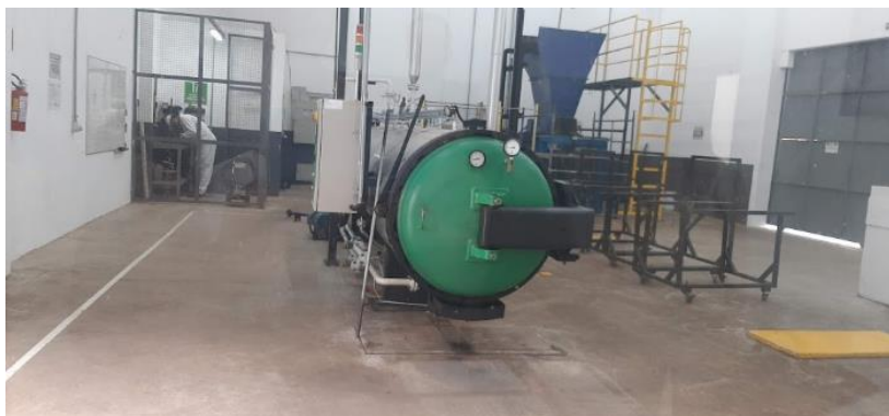
Figura 121: Vista interna da Unidade de Tratamento de Resíduos de Saúde - UTRSS.
