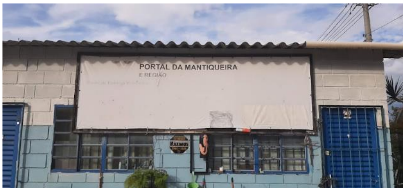
Figura 179: Placa de Identificação e escritório – PEV Mantiqueira.
