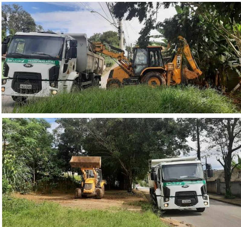
Figura 138: Coleta de entulho.
