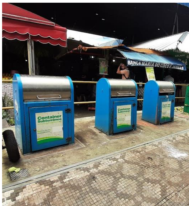
Figura 108: Contentores soterrados na feira central.
