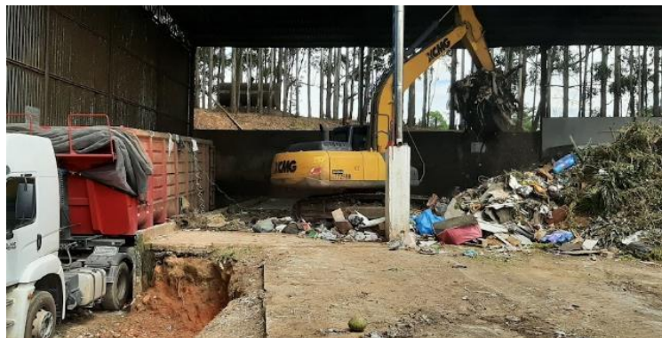
Figura 116: Retroescavadeira alimentando as caçambas.
