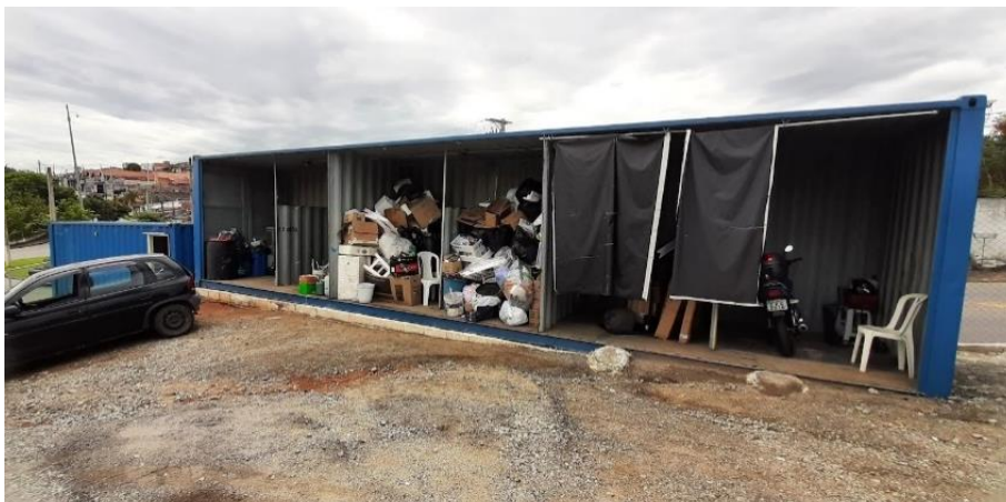
Figura 162: Local com baias para armazenamento de materiais.
