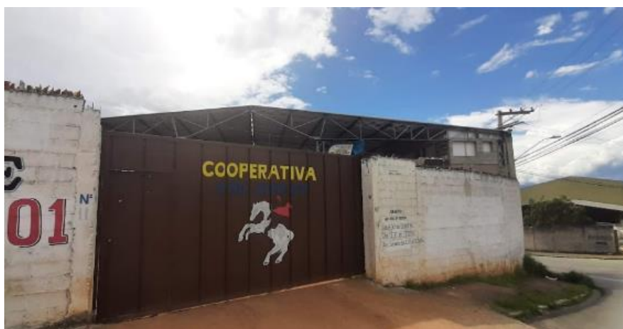
Figura 70: Vista externa da fachada.
