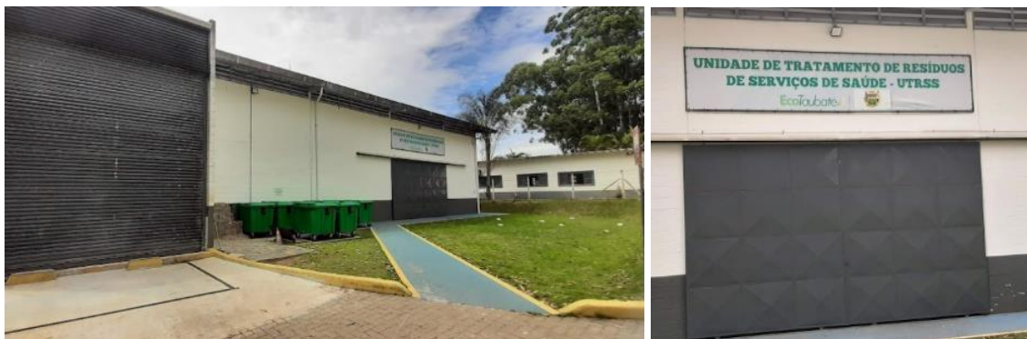
Figura 120: Vista externa da Unidade de Tratamento de Resíduos de Saúde - UTRSS.
