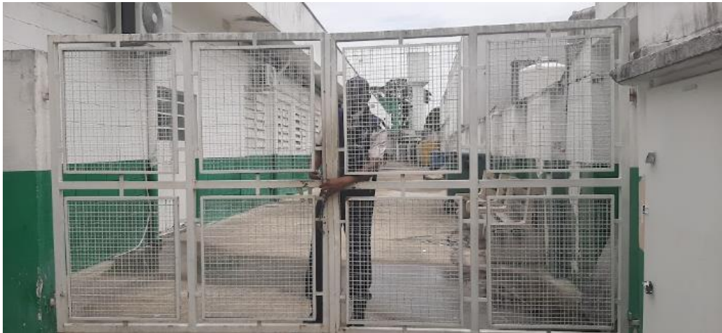
Figura 91: Acesso ao abrigo externo de RSS – Pronto Socorro Municipal.
