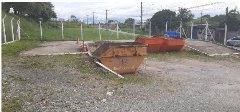
Figura 175: Vista geral interna - PEV Jardim Santa Tereza.
