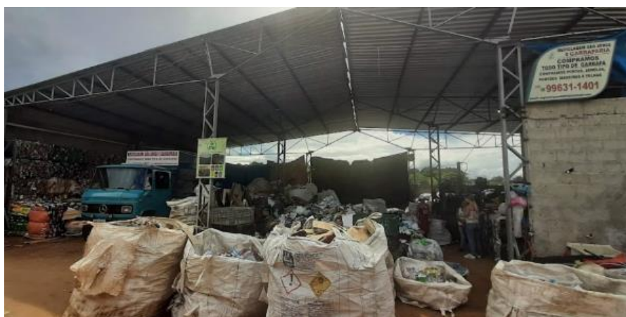
Figura 71: Vista geral do galpão aberto.
