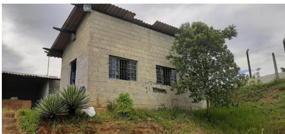
Figura 156: Estrutura com escritório, refeitório e banheiro.
