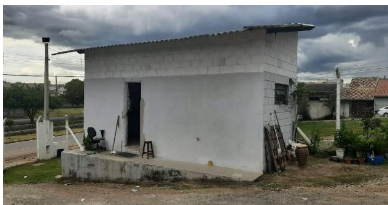
Figura 165: Unidade de apoio - PEV Parque Aeroporto.
