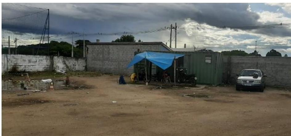
Figura 83: Vista da unidade de apoio.
