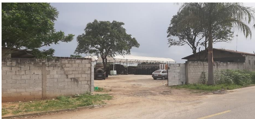
Figura 187: Vista a entrada do Ecoponto de Pneus.
