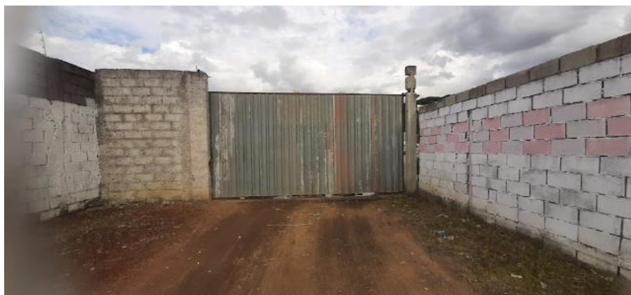
Figura 81: Vista externa da fachada.
