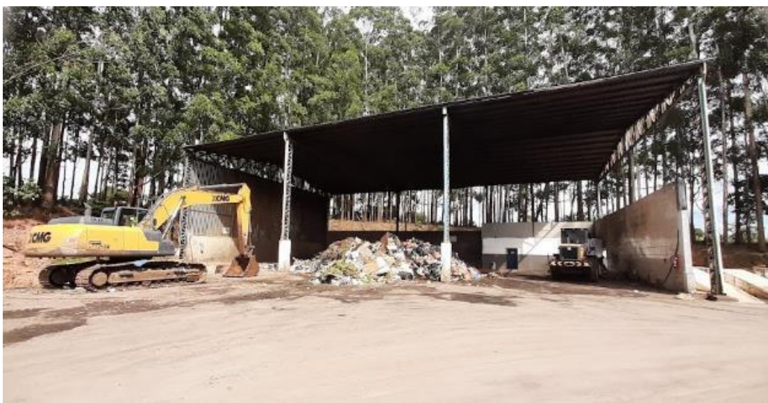
Figura 114: Vista externa da Estação de Transbordo.
