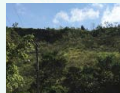
FIGURA 24 - EROSIÃO - VISTA 02 FONTE: ACERVO DO AUTOR, 2022
