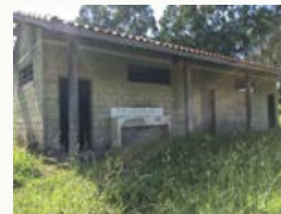
FIGURA 138 - SANITÁRIO 04 FONTE: ACERVO DO AUTOR, 2022
