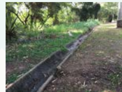
FIGURA 123 - VALA DE DRENAGEM FONTE: ACERVO DO AUTOR, 2022
