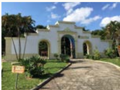
FIGURA 83 – ACESSO 01 FONTE: ACERVO DO AUTOR, 2022
