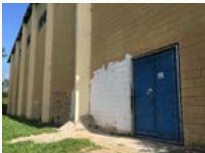
FIGURA 98 - QUADRA - VISTA EXTERNA FONTE: ACERVO DO AUTOR, 2022
