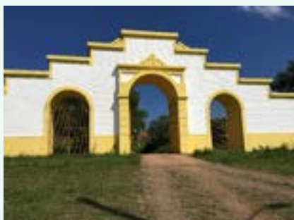
FIGURA 85 – ACESSO 02 FONTE: ACERVO DO AUTOR, 2022
