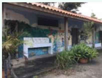
FIGURA 136 - SANITÁRIO 02 FONTE: ACERVO DO AUTOR, 2022
