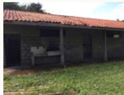
FIGURA 137 - SANITÁRIO 03 FONTE: ACERVO DO AUTOR, 2022
