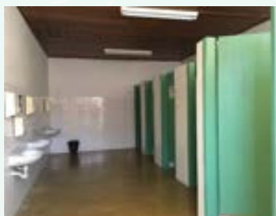
FIGURA 135 - SANITÁRIO 01 FONTE: ACERVO DO AUTOR, 2022
