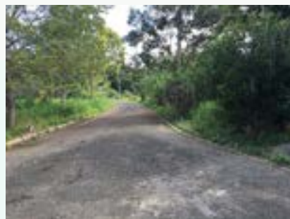
FIGURA 121 - PAVIMENTAÇÃO VISTA 02 FONTE: ACERVO DO AUTOR, 2022
