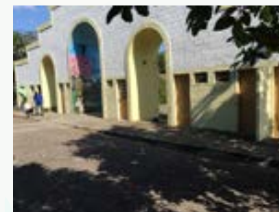
FIGURA 139 - SANITÁRIO DO PORTAL FONTE: ACERVO DO AUTOR, 2022
