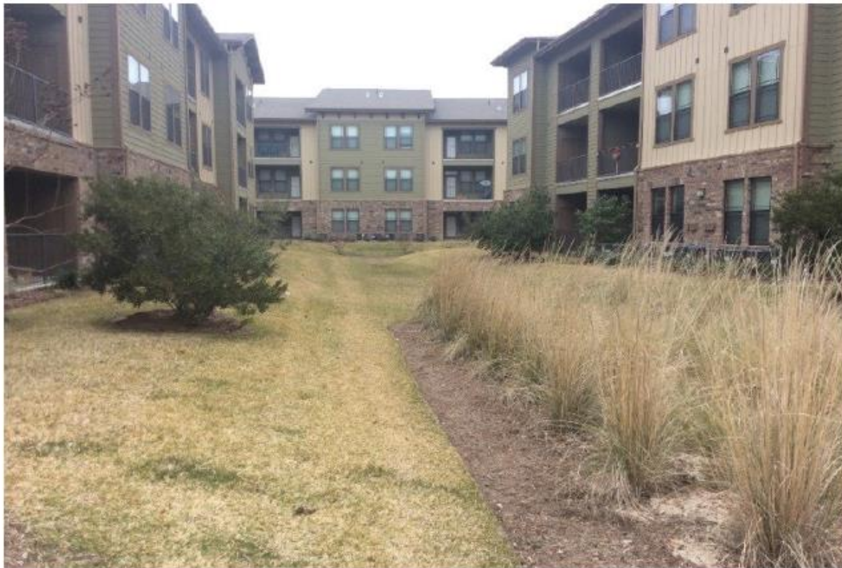
Figura 182. Condomínio Vertical Multifamiliar/Queenston Manor – Houston valas de infiltração, jardins de chuva, pavimentação permeável e cisternas subterrâneas (Acervo pessoal, Liz Accioli, 2016).
