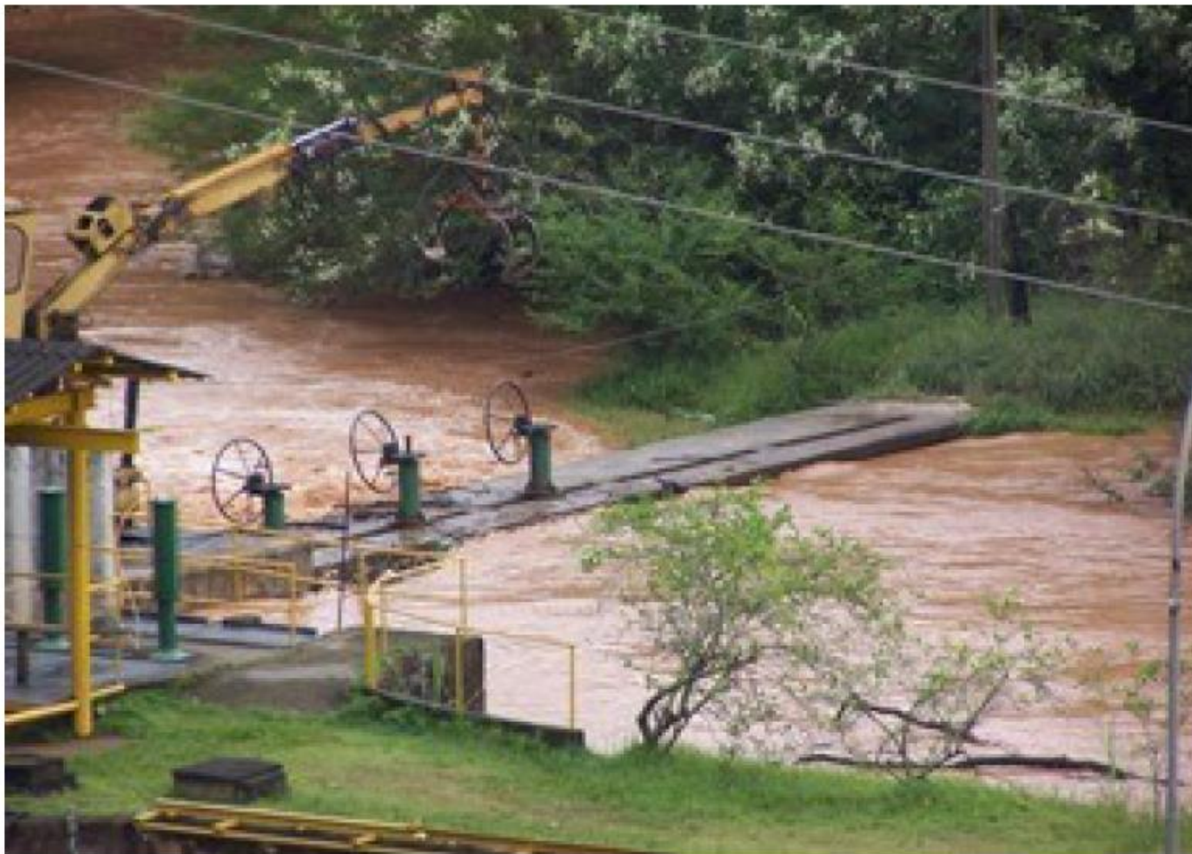
Figura 142. Estrutura de captação de Água da SABESP no rio Una, completamente afetada pela cheia do rio.
