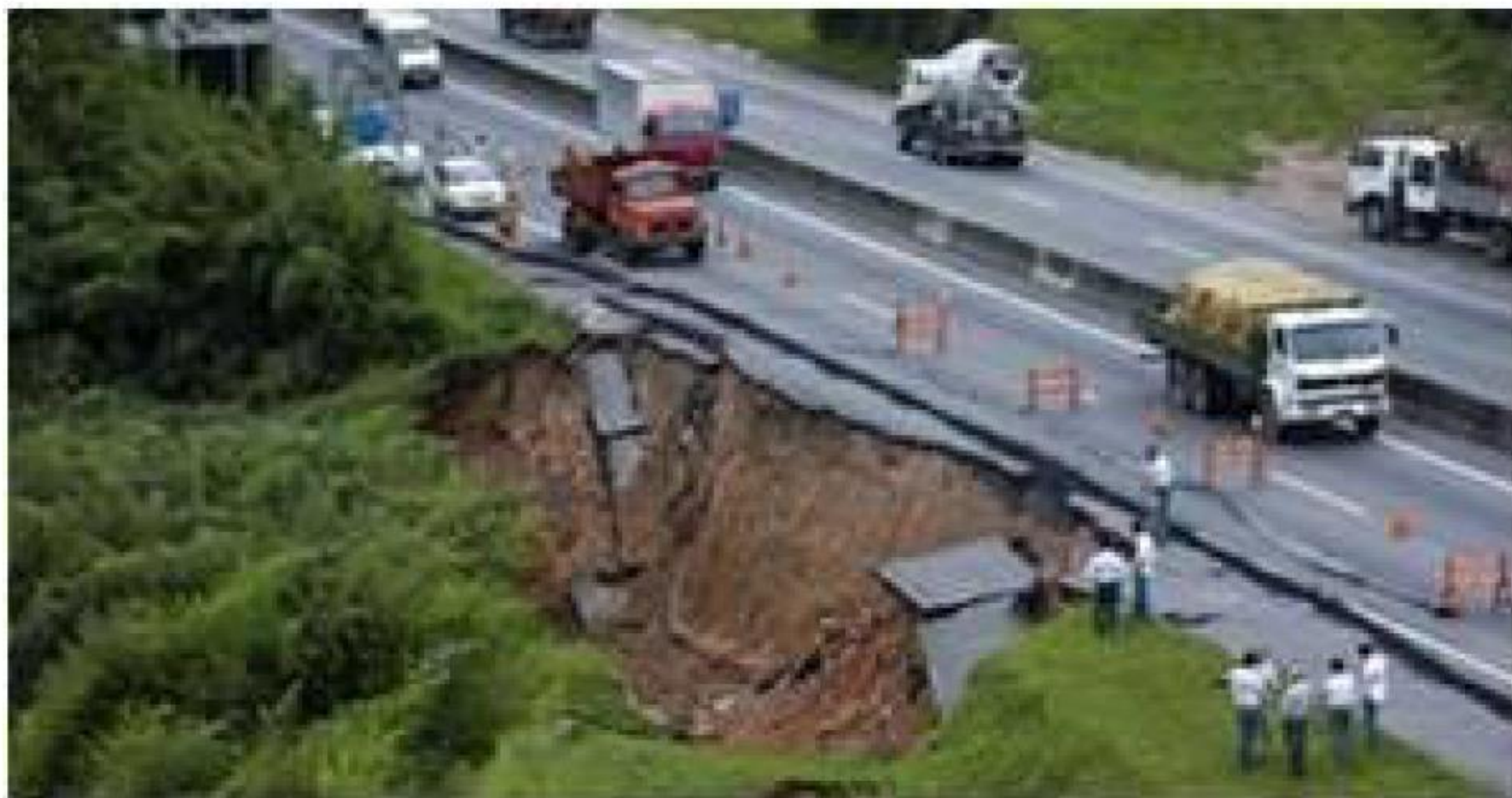
Figura 139. Outro ângulo dos danos na Rodovia Presidente Dutra junto À estrutura hidráulica sobre o rio Una.
