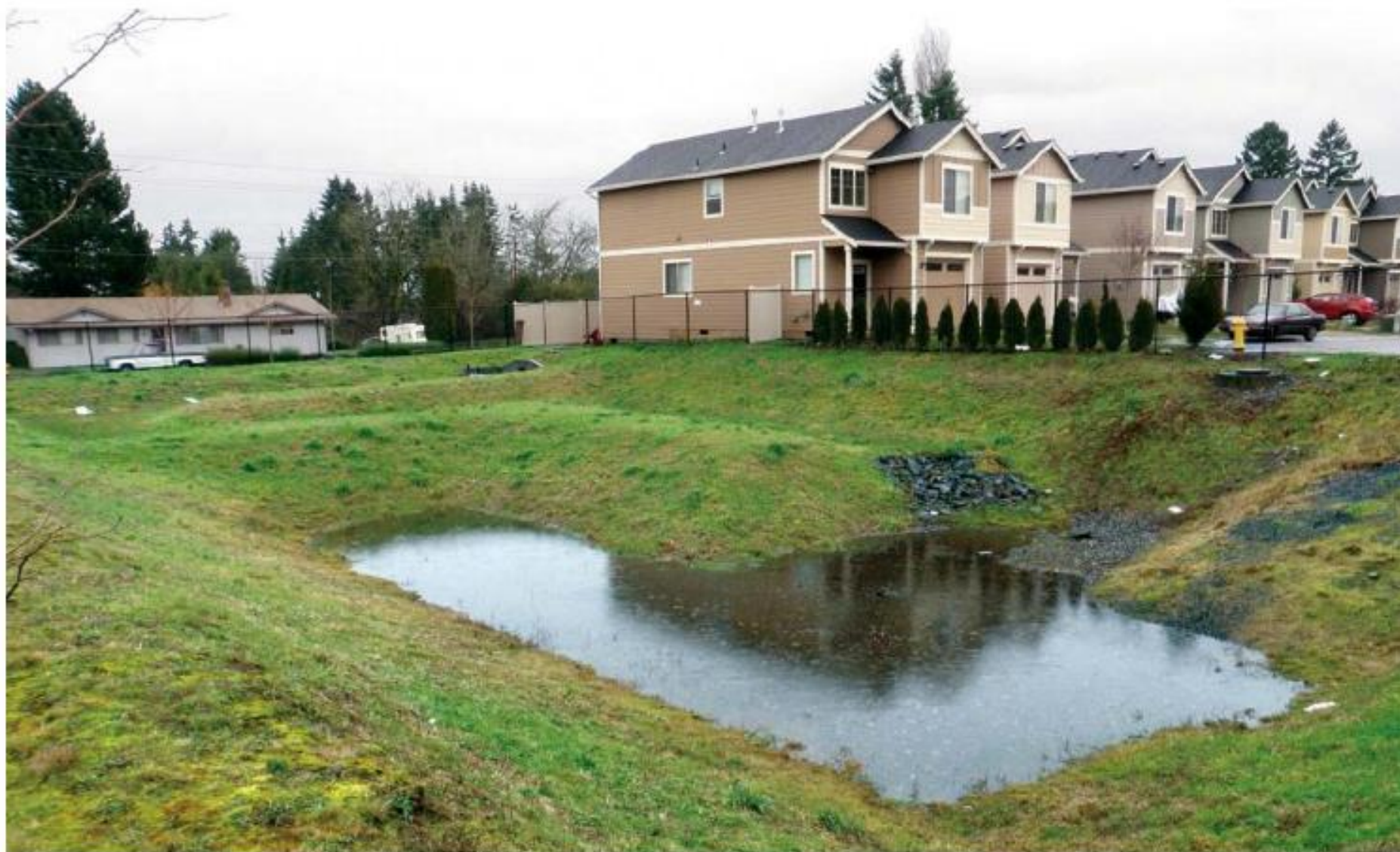
Figura 183. Bacia de detenção em condomínio em Vancouver. WA (USA).
