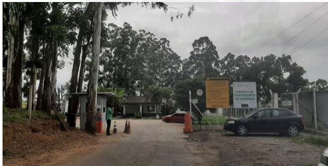
Figura 112: Entrada da Central de Tratamento de Resíduos Sólidos.
