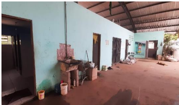
Figura 61: Vista geral da área destinada as unidades de apoio.
