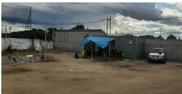
Figura 83: Vista da unidade de apoio.
