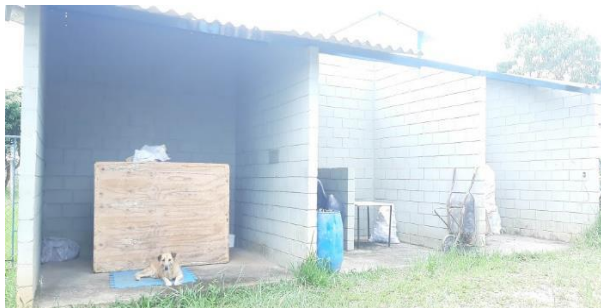
Figura 157: Local com baias para armazenamento de materiais.
