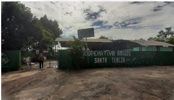
Figura 59: Vista externa – Fachada da Cooperativa Santa Tereza.
