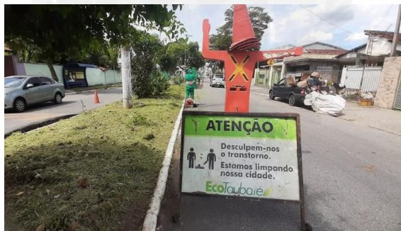
Figura 101: Identificação dos serviços.
