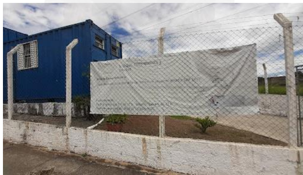
Figura 158: Vista externa - PEV Três Marias II.
