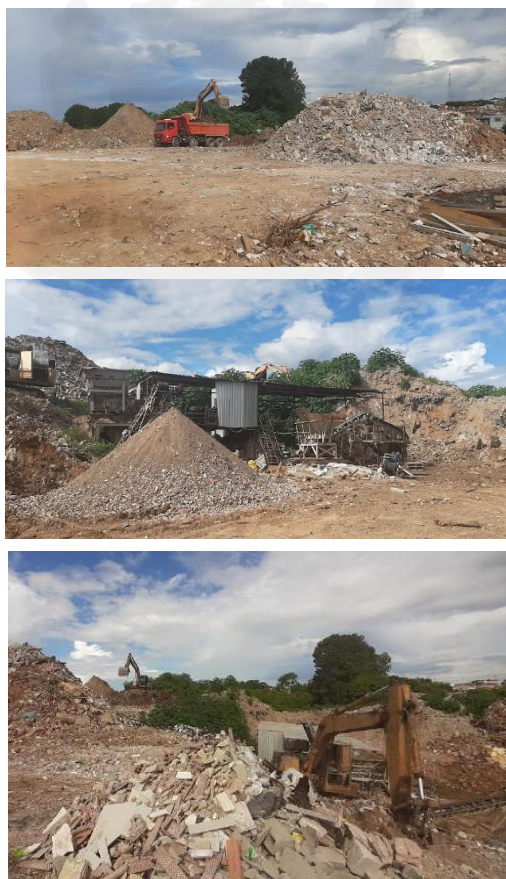
Figura 144: Resíduos da Construção Civil – RCC processados na empresa Alpha Ambiental.
