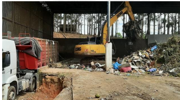
Figura 116: Retroescavadeira alimentando as caçambas.
