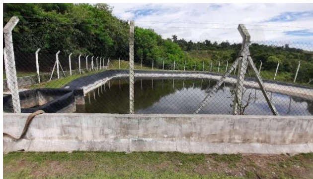
Figura 133: Vista geral da lagoa de armazenamento de chorume.
