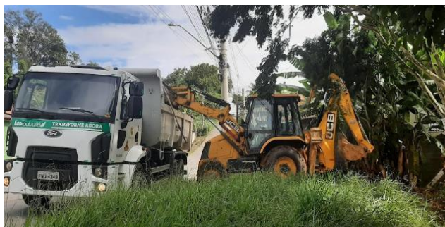
Figura 138: Coleta de entulho.
