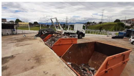
Figura 161: Caçambas do Pátio interno.
