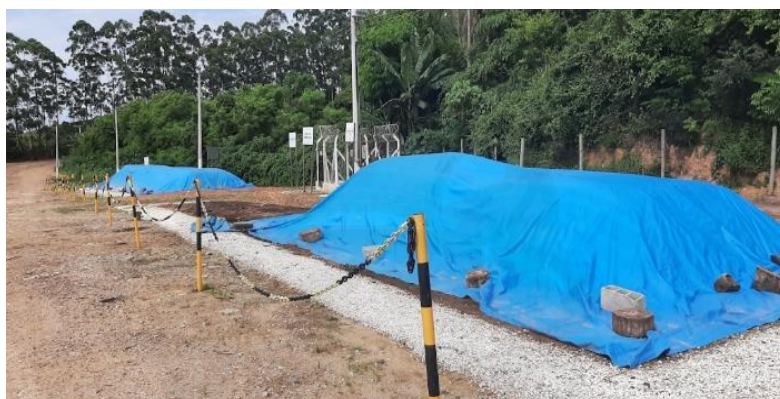
Figura 127: Pátio de aeração.
