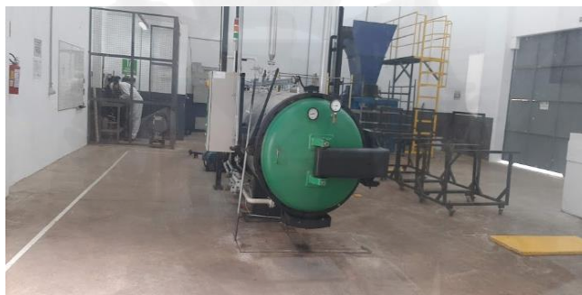
Figura 121: Vista interna da Unidade de Tratamento de Resíduos de Saúde - UTRSS.
