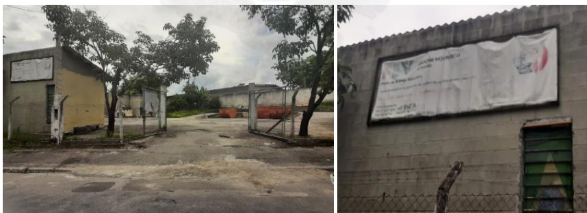
Figura 168: Vista da fachada – PEV Jardim Morisco.
