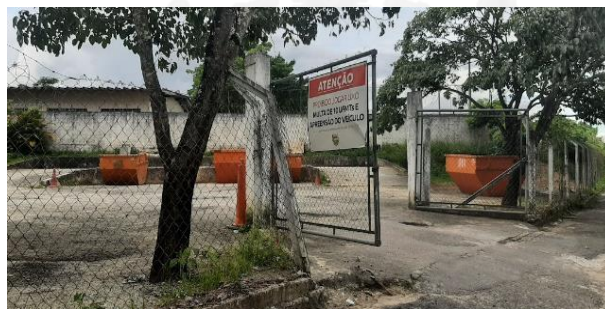
Figura 170: Vista da fachada – PEV Jardim Morisco.
