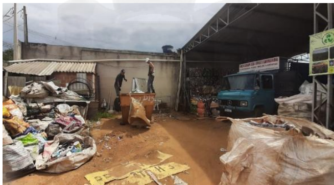
Figura 72: Vista interna do pátio.
