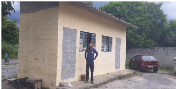
Figura 169: Unidade de Apoio – PEV Jardim Morisco.
