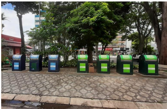
Figura 51: Contentores soterrados – Praça Central.
