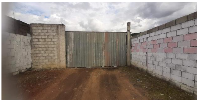
Figura 81: Vista externa da fachada.
