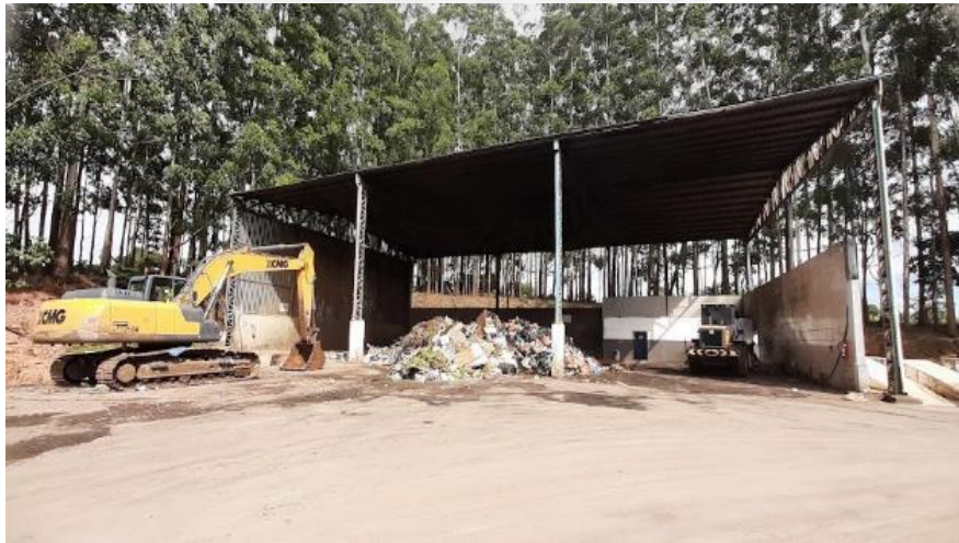
Figura 114: Vista externa da Estação de Transbordo.
