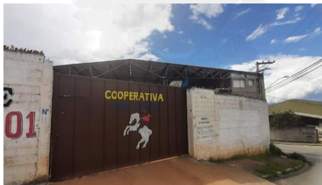
Figura 70: Vista externa da fachada.
