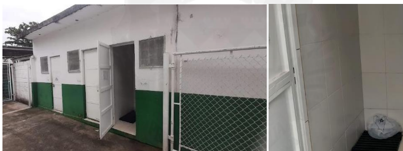
Figura 92: Abrigo externo de RSS – Pronto Socorro Municipal.
