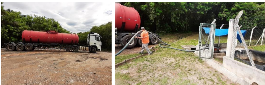
Figura 135: Caminhão tanque que coleta o efluente armazenado na lagoa.
