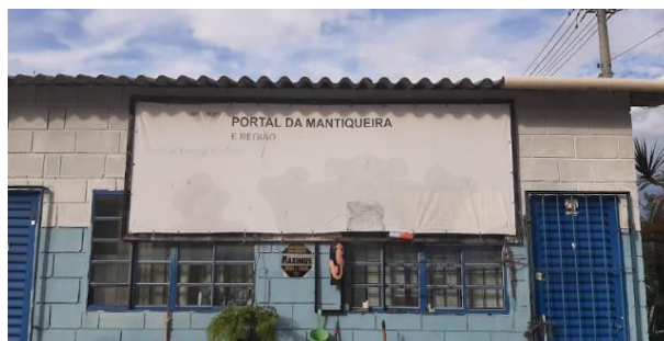
Figura 179: Placa de Identificação e escritório – PEV Mantiqueira.
