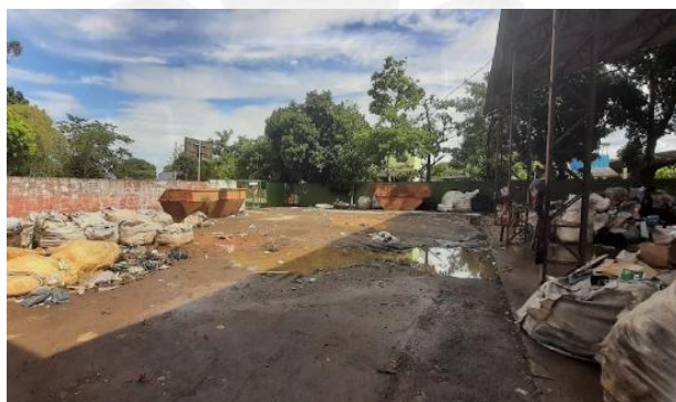
Figura 62: Vista geral do pátio.
