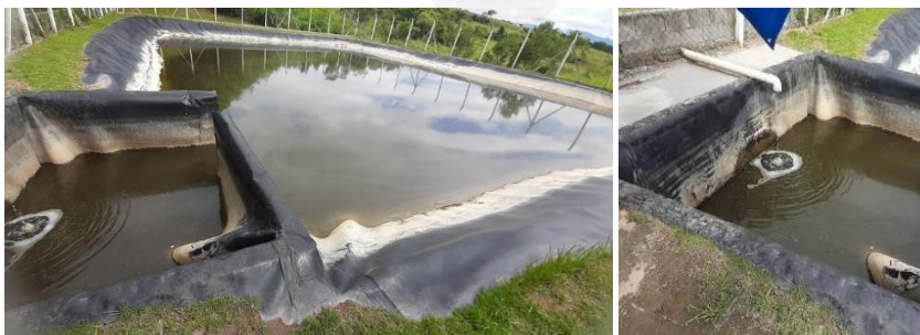
Figura 134: Lagoa de armazenamento de chorume.
