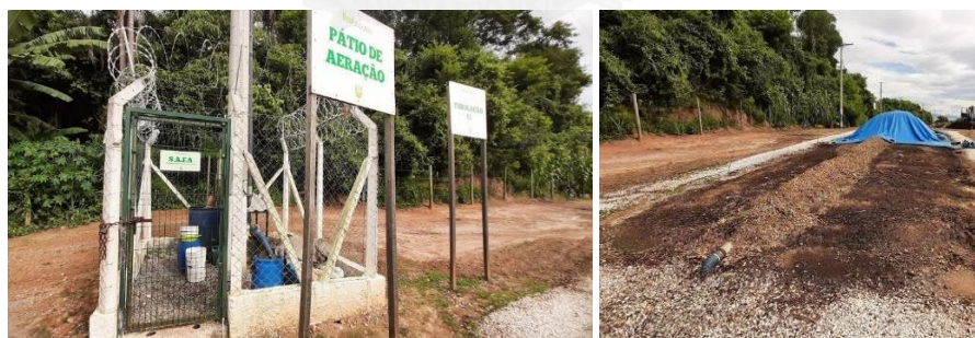
Figura 128: Sistema de Aeração - Pátio de aeração.
