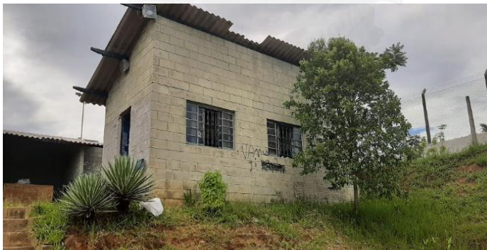
Figura 156: Estrutura com escritório, refeitório e banheiro.
