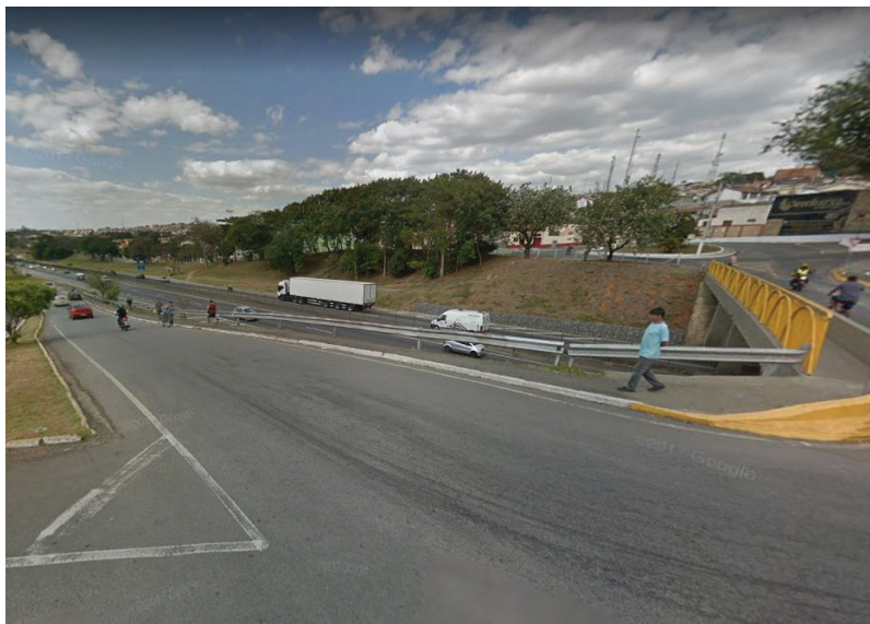
Imagem 1: Travessia elevada que garante o acesso de veículos motorizados entre as Marginais Fonte: Google Street, 2017
