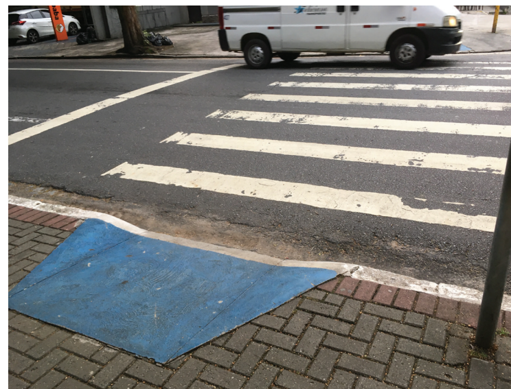
Foto 25: Sinalização horizontal na área Central Fonte: TcUrbes, 2019
