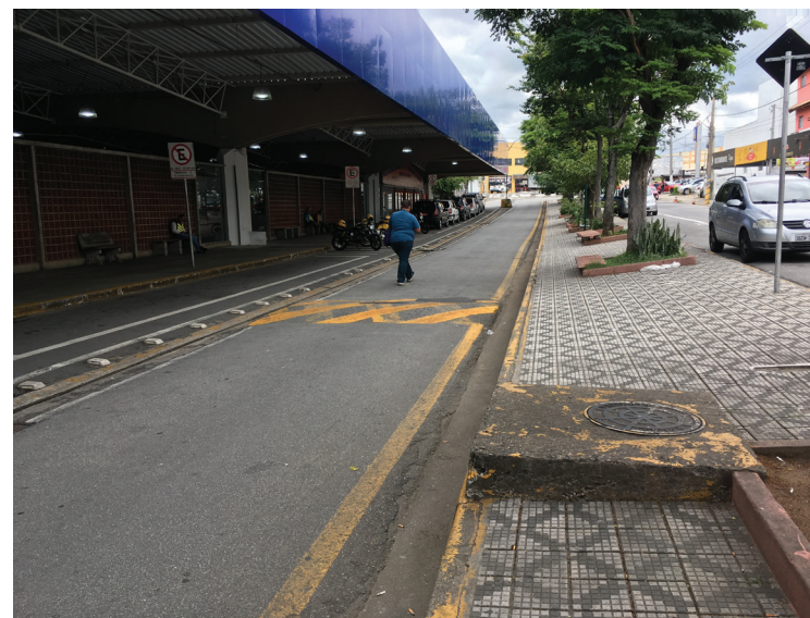
Foto 26: Sinalização horizontal na Rodoviária "nova" Fonte: TcUrbes, 2019
