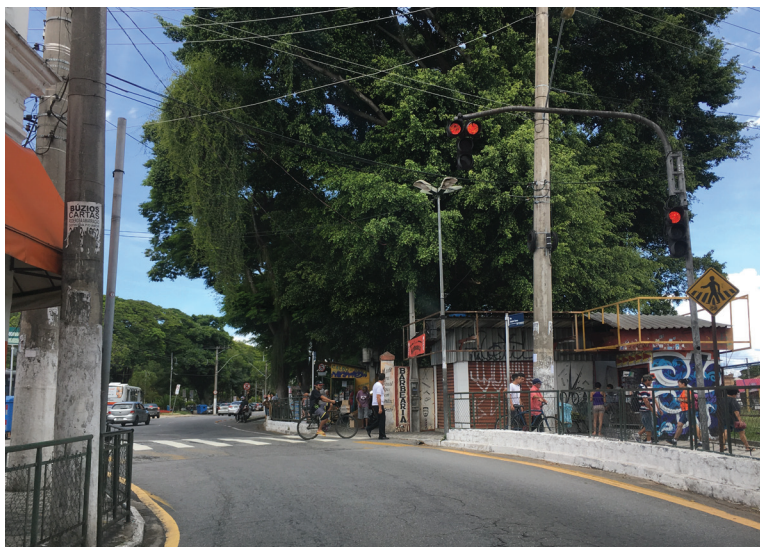
Foto 24: Travessia térrea e sinalizada na linha férrea Fonte: TcUrbes, 2019
