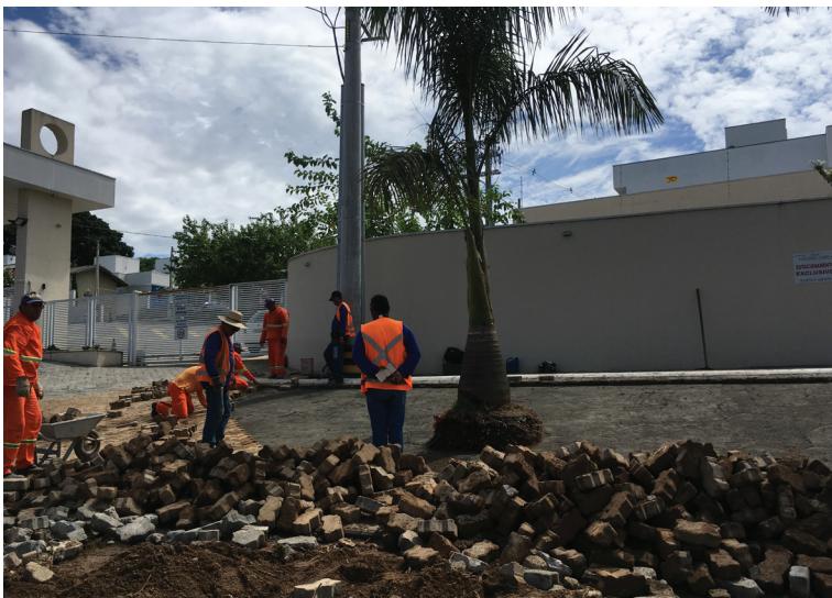
Foto 19: Requalificação de calçada na Estrada do Barreiro Fonte: TcUrbes, 2019
