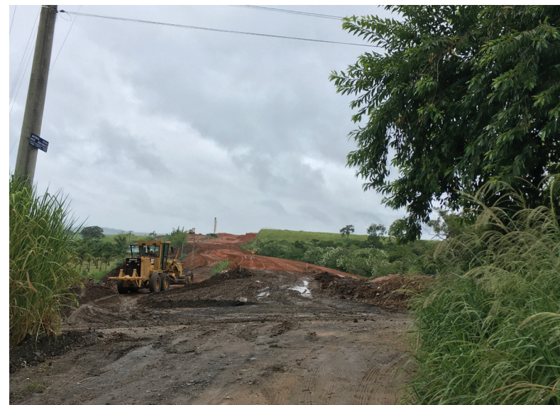
Foto 39: Obras do Sistema viário Quiririm Fonte: TcUrbes, 2019
