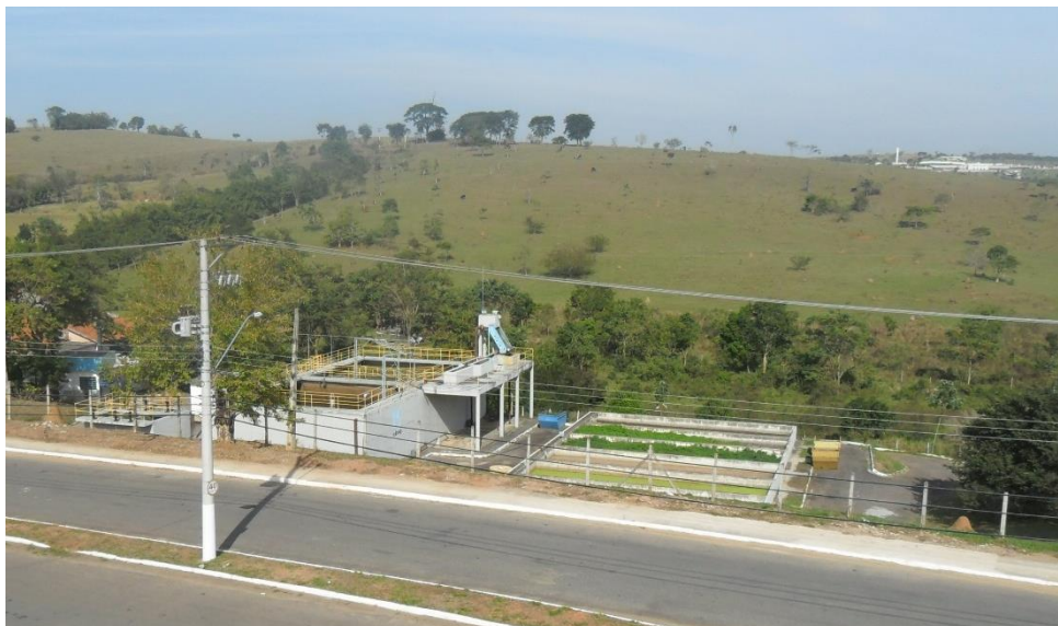
Figura 6.2.4-9. ETE do sistema isolado Marlene Miranda.
