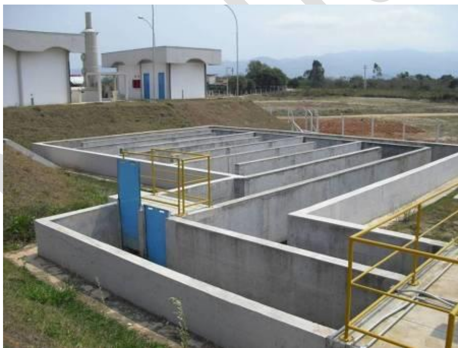
Figura 6.2.4-8. Tanque de contato onde acontece a desinfecção final do efluente.
