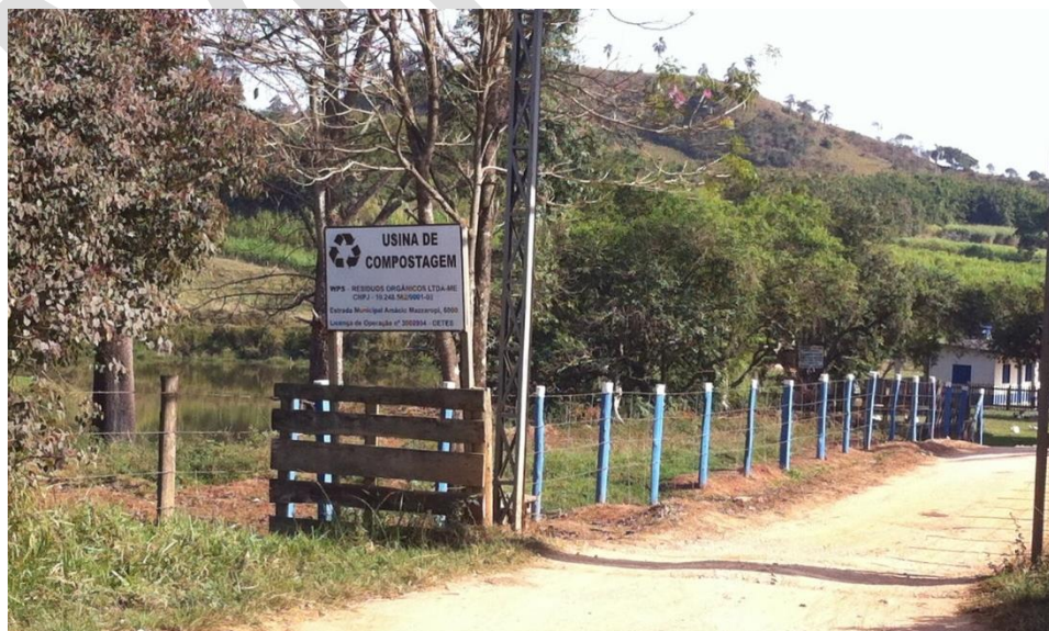
Figura 6.2.8.4-3. Entrada a usina de compostagem WPS, em Taubaté.
