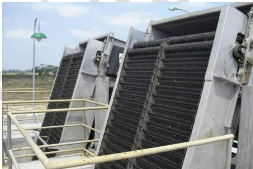
Figura 6.2.4-2. Gradeamento mecanizado para retirada de material grosseiro.
