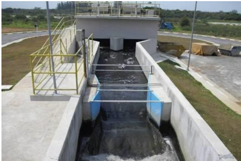
Figura 6.2.4-1. Calha Parshall para medição de vazão na entrada da ETE Tremembé/Taubaté.
