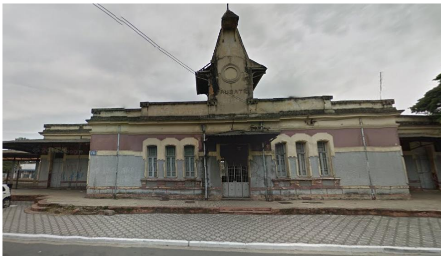
Figura 6.1.4.3-1. Estação Ferroviária de Taubaté.
